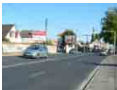
RN4 : aménagement en 2x 2 voie en section courante
